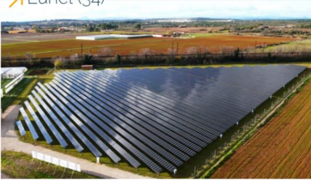
1 ère centrale solaire au sol en France métropolitaine
